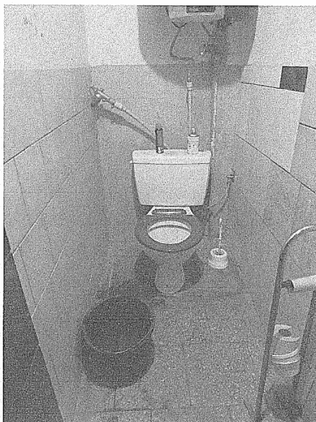
Dílňa – vnitřní prostor dílny – elektrický zásobníkový ohříváč TUV na WC
